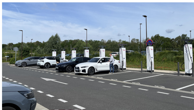
Stationnements pour véhicules électriques
