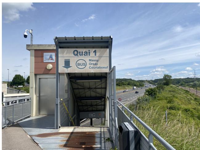
Accès au quai 1
