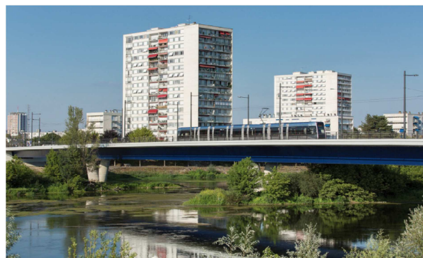
Un nouveau franchissement du Cher dédié au tramway et aux déplacements alternatifs à l'automobile
