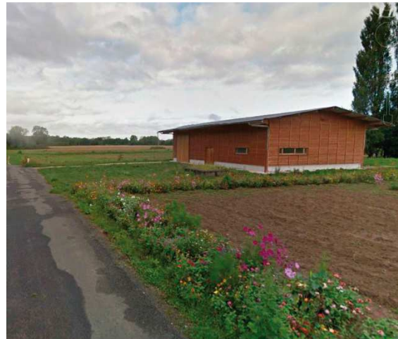
Bâtiment maraîcher en périphérie de l'agglomération tourangelle
