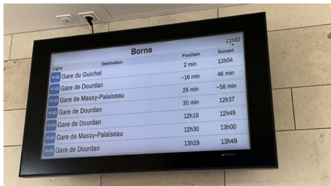
Affichage dynamique des horaires de cars installé dans le hall d'accueil des voyageurs
