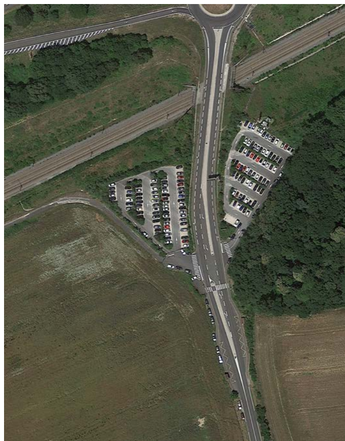
Le site du parc multimodal de Longvilliers en 2018 (simple aire de covoiturage)
